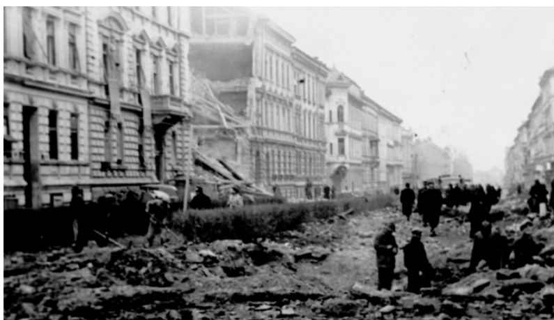
Abbildung 117: Aufräumarbeiten nach dem Bombentreffer in der Conrad von Hötzendorf-Straße 715
